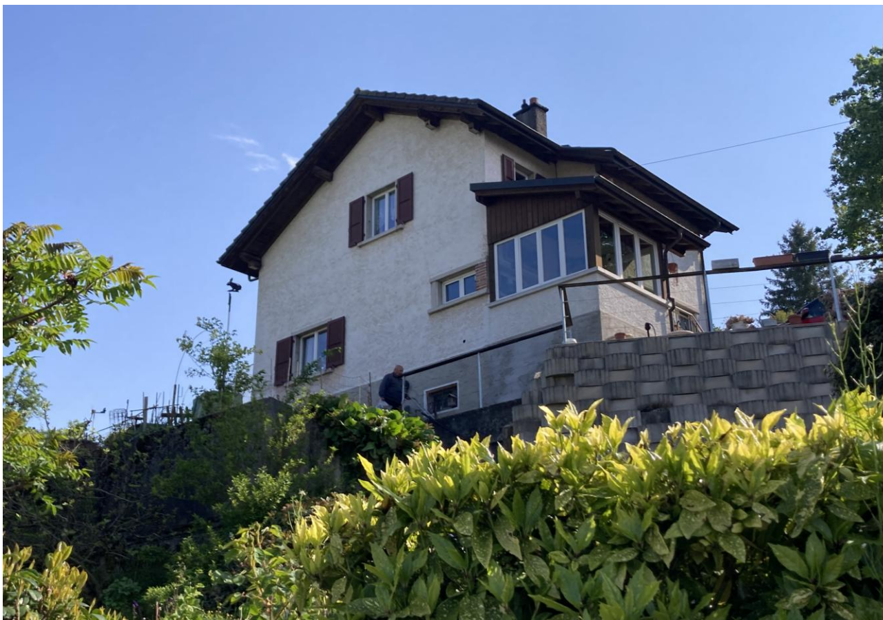
Rue des Uttins 33 où trois nichoirs ont été insérés sous les pannes du toit. La réalisation est aussi esthétique qu'efficace, avec deux nichoirs occupés en 2024.
